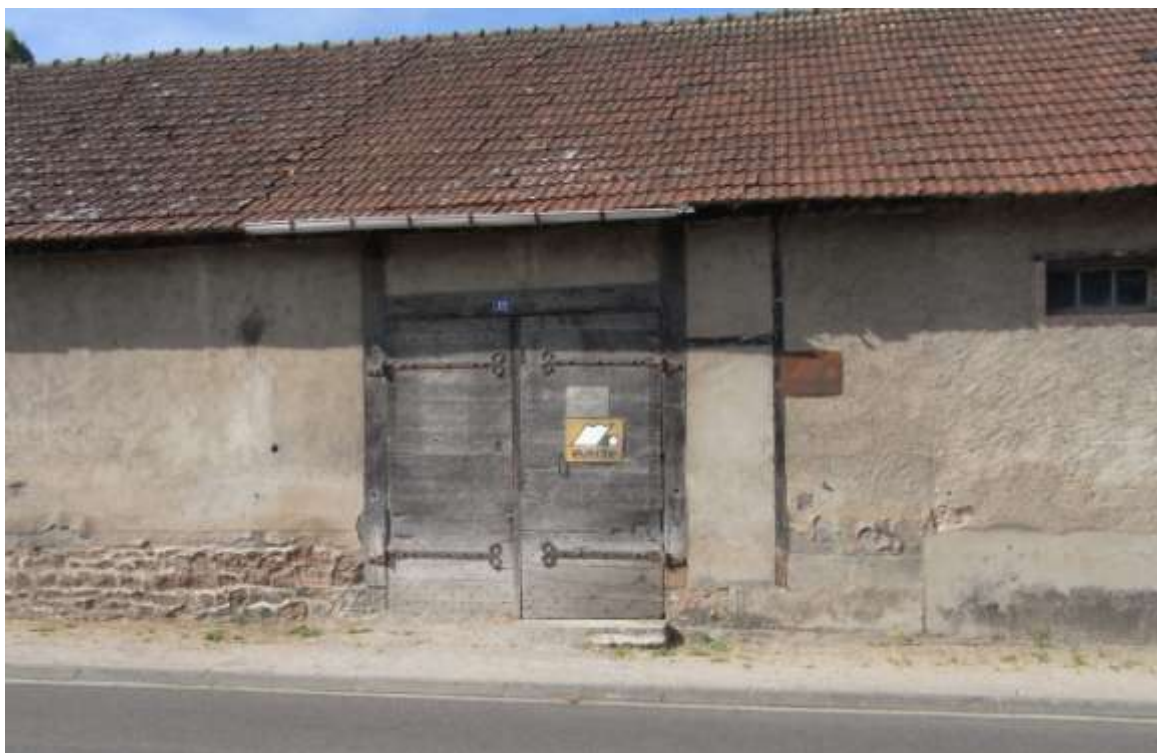
Porte à double-vantail de l'ancienne église de Cosne réutilisée dans la dépendance au N°10, vantaux inversés gauche/droite
